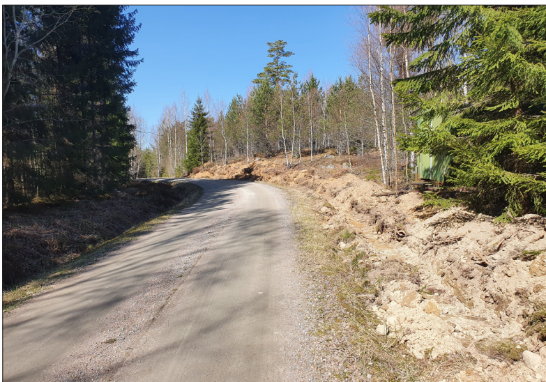
Översikt av schaktet söder om boplatsen mellan punkt B och C. I bilden kan man tydligt se skillnaden mellan den gråa silten i förgrunden och den rödgula sanden i bildens bakre del. Bilden är tagen från öster. Foto: Patrik Gustafsson Gillbrand 2021, Sörmlands Arkeologi AB.
