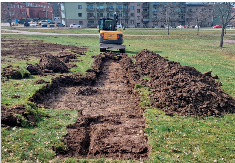
Schakt 208 med A199 centralt i bilden (efter undersökning). Foto mot västsydväst: Lars Norberg 2024, Sörmlands Arkeologi AB.
