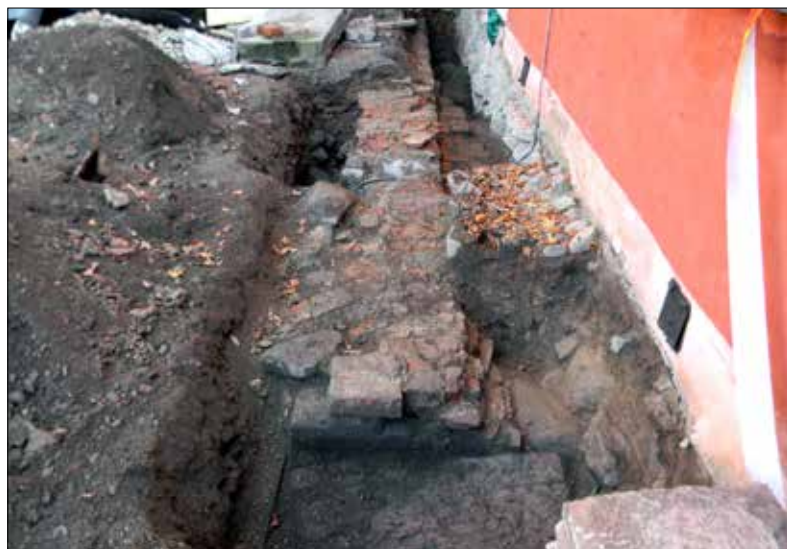
Figur 5. Vid förundersökningen förlängdes schakt 1 cirka 3 meter åt nordväst. Här påträffades ett murhörn. Muren befanns även vika av in under Ståthållarflygeln åt väster. Här fanns dock endast murens grundstenar kvar. Muren bör ha utgjort väggarna till en byggnad. Närmast i bild kan man ana en kalkstensplatta in situ. Bilden är tagen från nordväst. Foto: Patrik Gustafsson Gillbrand 2016, Sörmlands Arkeologi AB.
