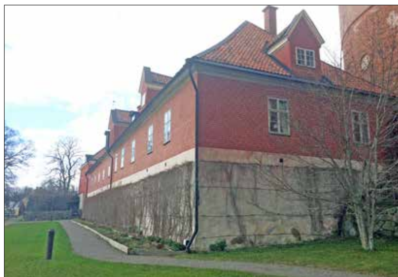
Figur 6. Sydvästra hörnet av Ståthållarflygeln. Notera den höga terrassen som byggnaden är uppförd på. I dess nedersta del kan man ana att terrassens är uppförd i sten som tittar fram ur putsen. Förmodligen utgör terrassen den undre delen av den västra sträckmuren. Bilden är tagen från sydväst. Foto: Patrik Gustafsson Gillbrand 2016, Sörmlands Arkeologi AB.
