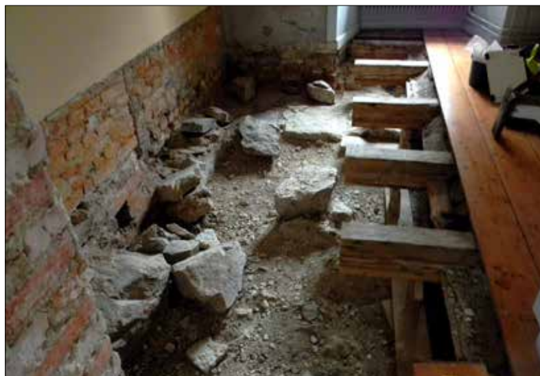
Figur 7. Översikt av schakt 2 som återfanns i det sydöstra rummet inne i Ståthållarflygeln. I bildens bakre del kan man ana den påträffade muren av flata stenar. Övriga stenar tillhör fundament till Ståthållarflygeln. Bilden är tagen från nordväst. Foto: Patrik Gustafsson Gillbrand 2016, Sörmlands Arkeologi AB.
