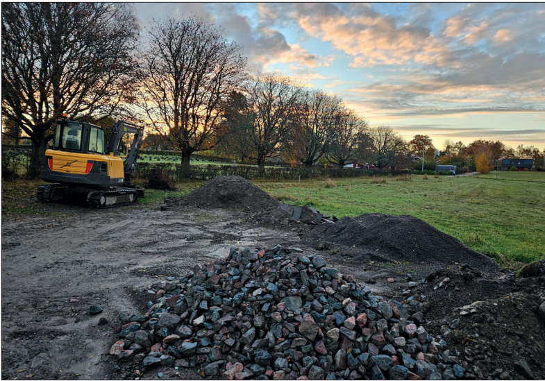
Översikt över den NV delen av undersökningsområdet före schaktning. I förgrunden upplagda massor från det pågående bygget av GC-vägen. Till vänster i bild syns Västerljungs nya kyrkogård. Foto mot sydost: Lars Norberg 2025, Sörmlands Arkeologi AB.
