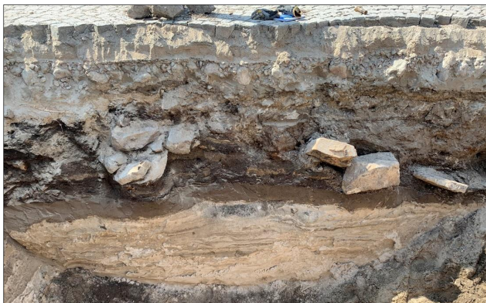
Figur 13. Foto över västra schaktväggen som illustrerar lagerdjup och de i schaktet påträffade lager och rester av huskonstruktion. Foto från öster taget av Ellinor Larsson, Värmlands Museum.
