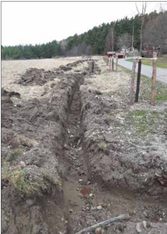
För att inte skada den nyplanterade allén grävdes schaktet i anslutning till Ytterselö 192:1 en bit från väggkanten (område 2). Bilden är tagen från sydöst. Foto: Ingeborg Svensson 2018, Sörmlands Arkeologi AB.
