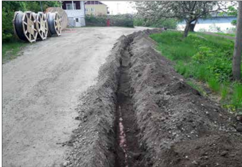
Den sydöstra delen av schaktet längs med vägen invid Ytterselö 152:1 (område 3). I botten av schaktet syns markeringen (rosa) för en VA ledning. Bilden är tagen från nordväst. Foto: Ingeborg Svensson 2018, Sörmlands Arkeologi AB.
