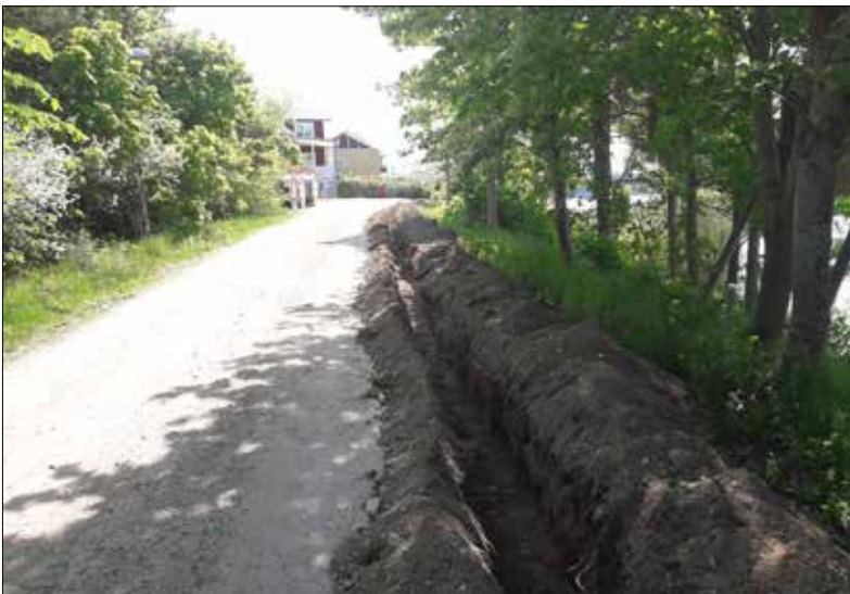
Den mellersta delen av schaktet i väggkanten invid Ytterselö 152:1 (område 3). Bilden är tagen från nordväst. Foto: Ingeborg Svensson 2018, Sörmlands Arkeologi AB.
