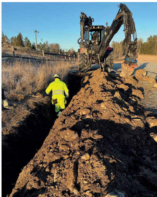
FIGUR 3. Kabelschaktet med gravfältet L1984:4760 till vänster i bild. Foto: Lars Sundström, SAU.
