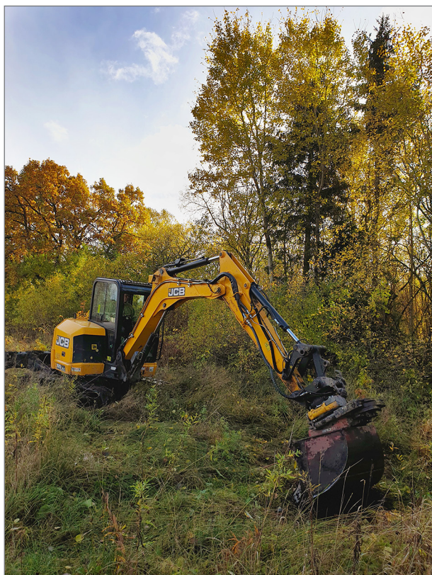
Figur 4. Schaktning med larvgående grävmaskin.
