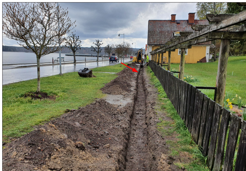
Schakt 1. Bilden är tagen från norr. Den röda pilen pekar på den nordligaste stenen som framkom i schaktet. Foto: Patrik Gustafsson Gillbrand 2021, Sörmlands Arkeologi AB.
