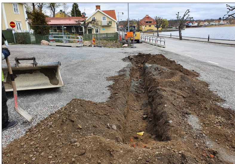
Schakt 2. Bilden är tagen från söder. Foto: Patrik Gustafsson Gillbrand 2021, Sörmlands Arkeologi AB.
