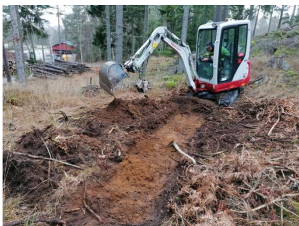
Fig. 7 Grävning av sökschakt 30 på lokal 2. Foto mot SV.
