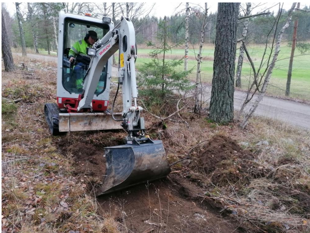
Fig. 5 Schaktning i utredningsområdets södra del. I bakgrunden syns golfbanan. Foto mot SO.
