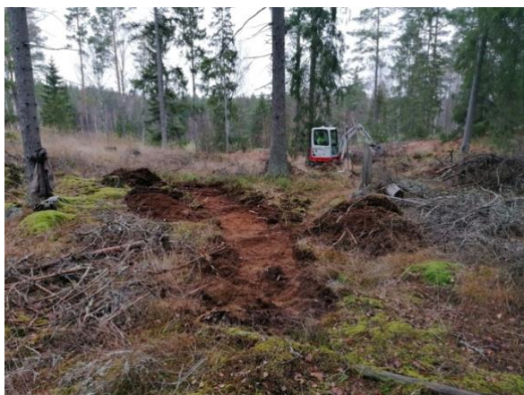
Fig. 9 Lokal 13. I mitten av bilden syns sökschakt 37. Foto mot N. Anläggning A1 ligger strax till höger om grävmaskinen.
