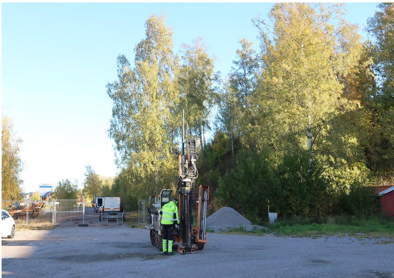
Figur 3. Geoteknisk skruvborr under borrning. Foto från sydväst, Annika Nordström.
