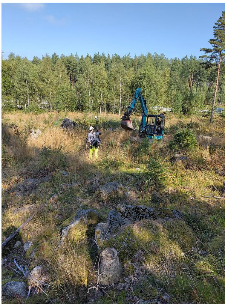
FIGUR 14. Schaktningsarbete inom arbetsyta nr 133. Foto mot öster: Astrid Brozén, SAU.
