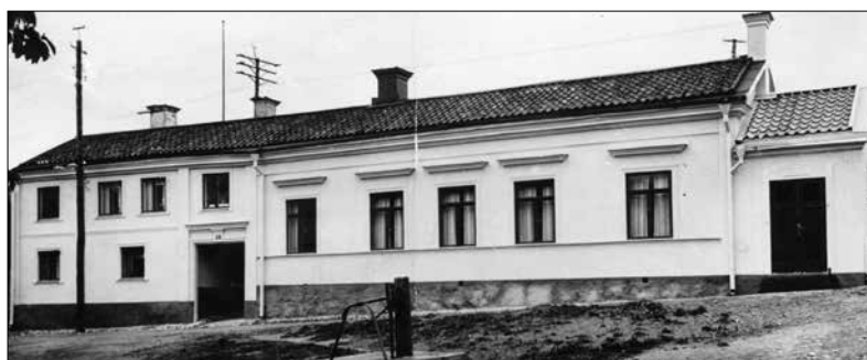
Figur 7. Blåbandsföreningens lokal (senare Viljansgården) mot Västerviksgatan och Pumptorget. Notera utbyggnaden till höger. Den motsvarar sannolikt den påträffade husgrunden (A4). Bilden är från 1920-21. Fotograf okänd. Strängnäs kommun, Multeum. Bild nr B35:4R.
