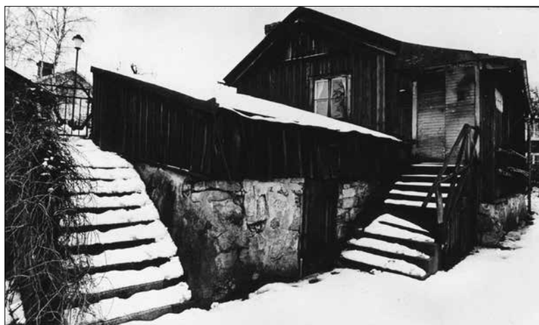
Figur 5. Den numera rivna stugan med den intilliggande källaren invid Kvarngatan (5-7). Delar av trappen till vänster i bild återfanns i samband med förundersökningen. Bilden är från omkring sekelskiftet 1900. Fotograf okänd. Strängnäs kommun, Multeum. Bild nr A22:9R.
