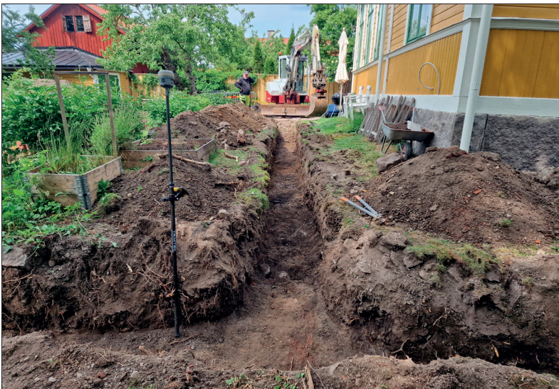
Ledningsschaktet väster om befintlig byggnad. Foto mot norr: Lars Norberg 2025, Sörmlands Arkeologi AB.
