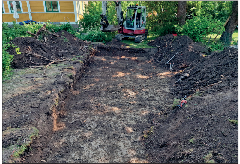
Delar av schakt för nybyggnation. Foto mot öster: Lars Norberg 2025, Sörmlands Arkeologi AB.
