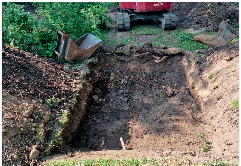
Schakt för stenkista. Foto mot norr: Lars Norberg 2025, Sörmlands Arkeologi AB.
