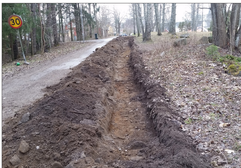
Den nordöstra delen av schaktet. Bilden är tagen från nordöst. Foto: Ingeborg Svensson 2017, Sörmlands Arkeologi AB.
