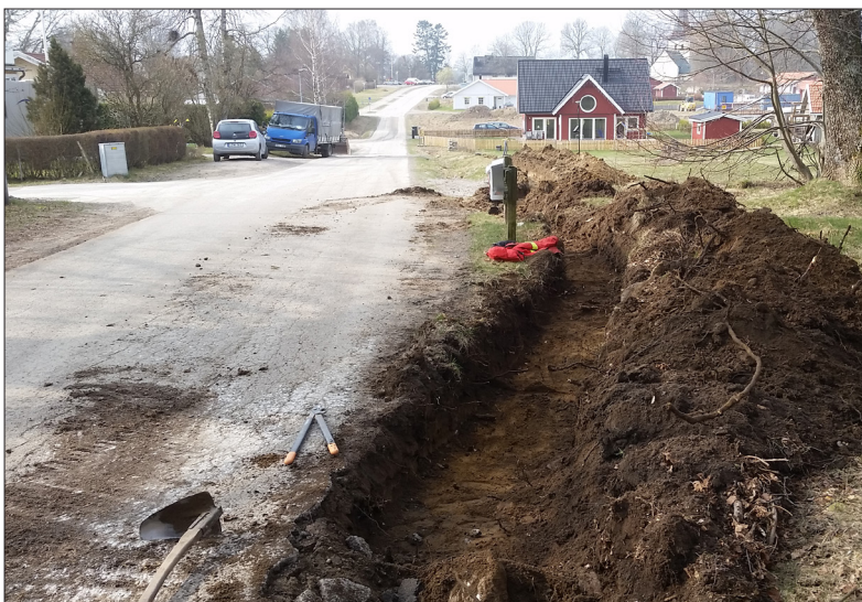
Den sydvästra delen av schaktet. Bilden är tagen från nordöst. Foto: Ingeborg Svensson 2017, Sörmlands Arkeologi AB.
