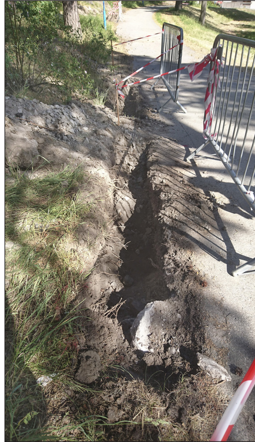
Figur 4. Foto över schakt 2.
