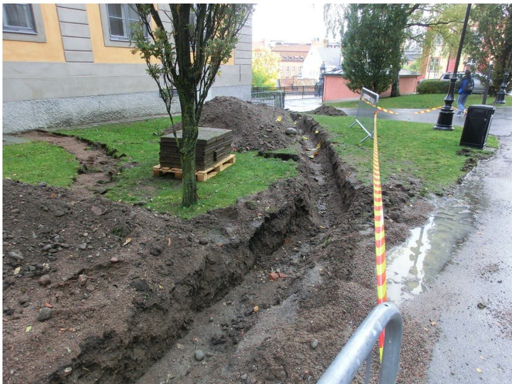
Figur 3. Foto på det grävda schaktet ner mot byggnadens sydöstra hörn. Foto från sydväst 2014-10-08, Bent Syse.
