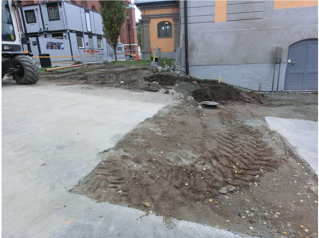
Figur 4. Schaktytan sett från nordost efter att rören lagts ner. Foto 2014-10-15, Bent Syse.
