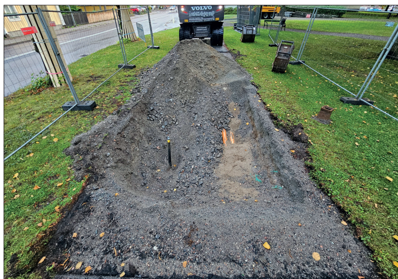
Schaktgrop 1 före grävning. Foto mot nordost: Lars Norberg 2025, Sörmlands Arkeologi AB.
