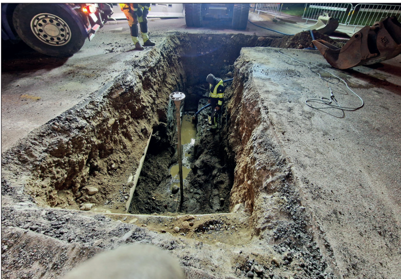
Schakt 2 grävt i botten med ventilen synlig i förgrunden. Foto mot ostsydost; Lars Norberg 2025, Sörmlands Arkeologi AB.
