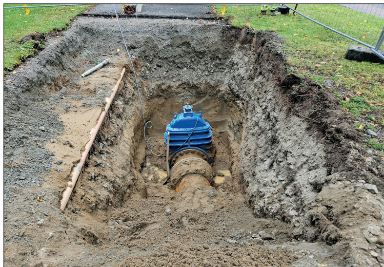
Schaktgrop 1 med ventil och del av rörledning framtagen före grävning. Foto mot sydväst: Lars Norberg 2025, Sörmlands Arkeologi AB.
