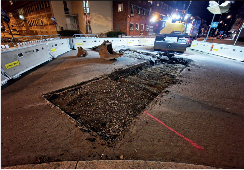
Schaktgrop 2 före grävning. Foto mot nordväst; Lars Norberg 2025, Sörmlands Arkeologi AB.
