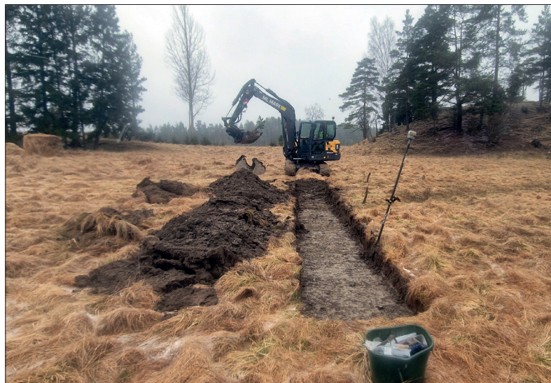
Schakt 3584. Foto mot norr: Lars Norberg 2024, Sörmlands Arkeologi AB.
