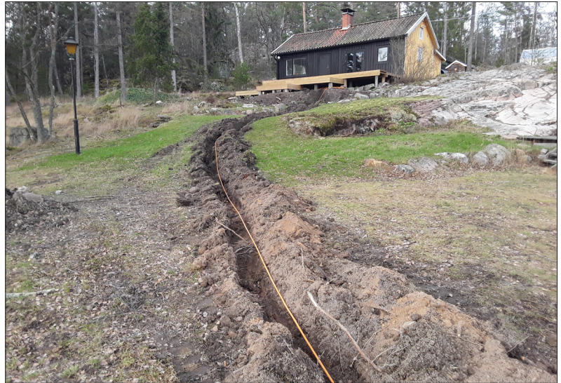
Utredningsschakt (schakt 4). Bilden är tagen från sydöst. Foto: Patrik Gustafsson Gillbrand 2020, Sörmlands Arkeologi AB.
