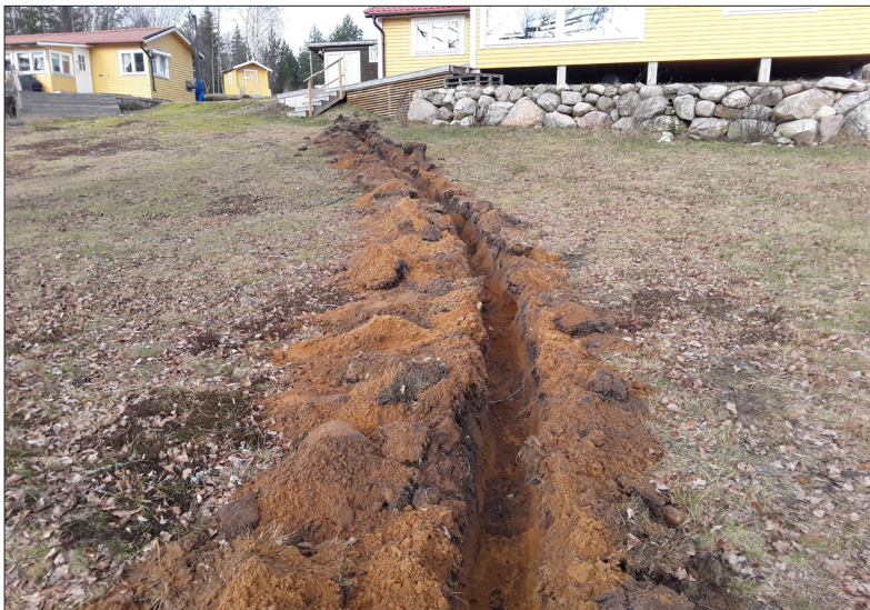
Schakt 5. Bilden är tagen från sydsydöst. Foto: Patrik Gustafsson Gillbrand 2020, Sörmlands Arkeologi AB.
