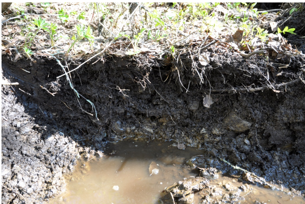
Bild 1. Profil från provschakt vid transformatorstationen norr om vägen, sett mot NÖ.
