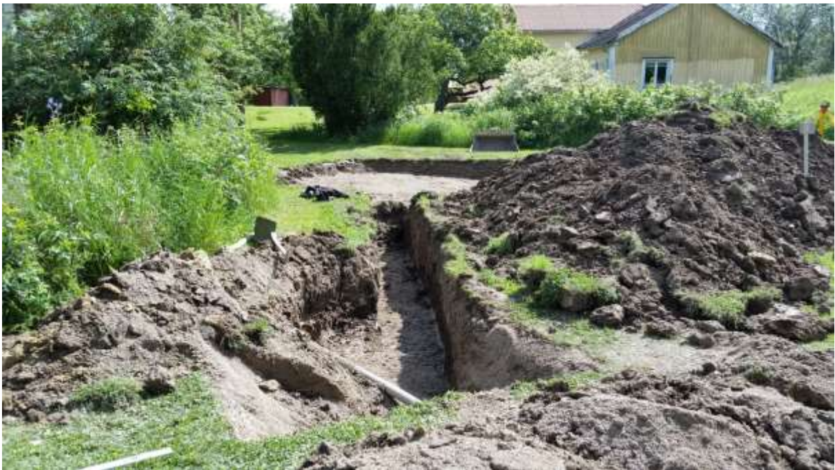
Figur 2. Norra delen av förundersökningsschaktet mot öster. I förgrunden syns en del av den befintliga VA-ledningen. Foto: Lars Norberg 2015, Sörmlands Arkeologi AB.
