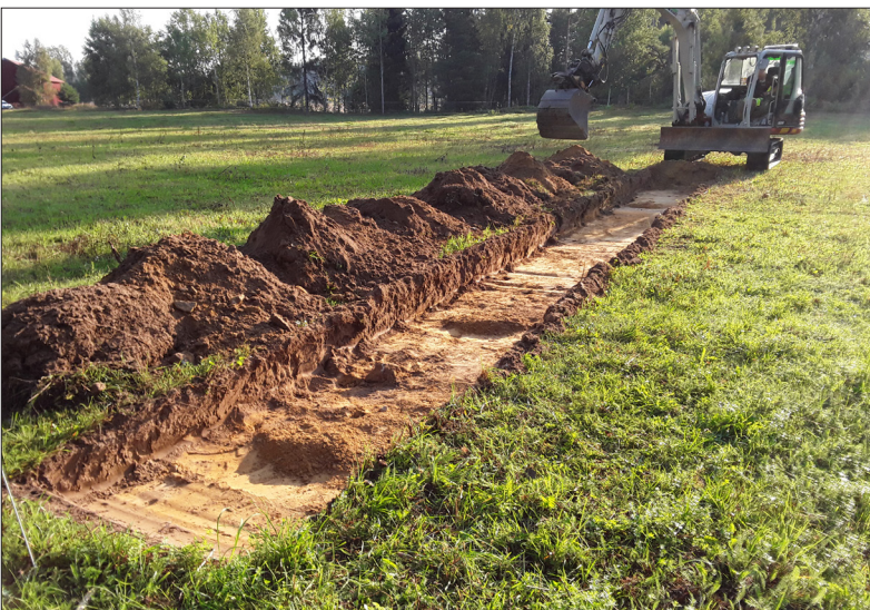
Arbetsbild med schakt 100 inom objekt 1 vid Ullevi. Bilden är tagen från sydväst. Foto: Patrik Gustafsson Gillbrand 2019, Sörmlands Arkeologi AB.
