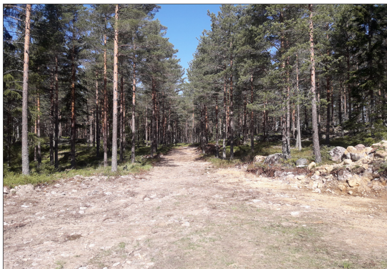
Figur 2. Centralt i bilden finns den påbörjade basvägen. Boplatsen är belägen i den bortre delen av schaktet. I förgrunden syns delar av en vändplan. Bilden är tagen från sydöst. Foto: Patrik Gustafsson Gillbrand 2018, Sörmlands Arkeologi AB.
