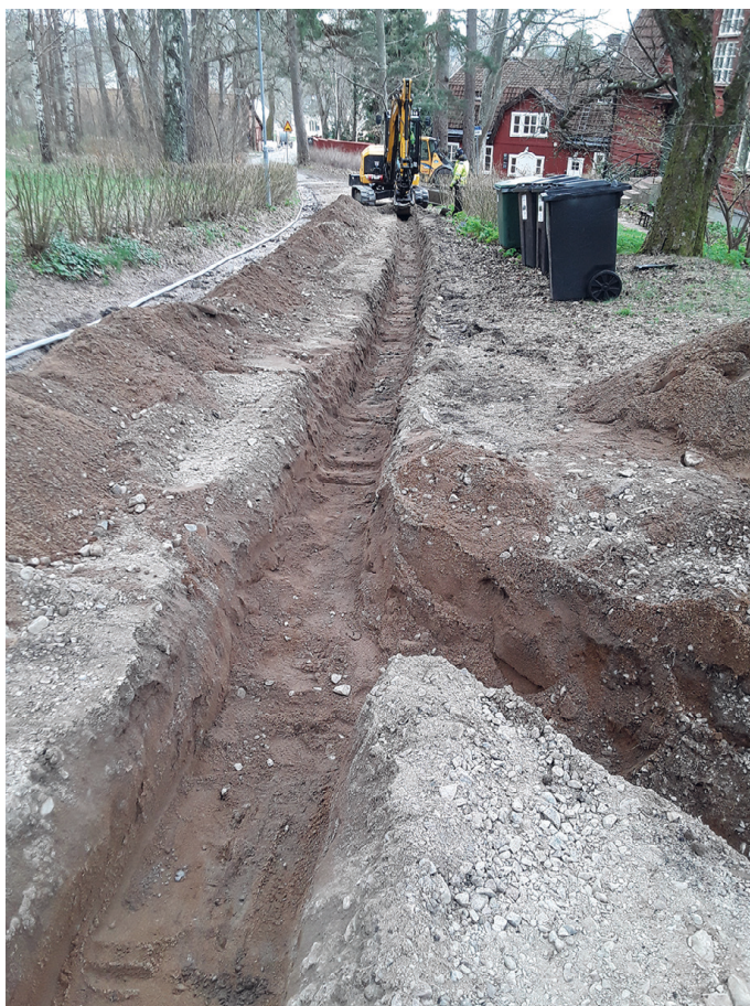
FIGUR 6. Schakt 2 och 3 vid Kronåsvägen. Mot sydöst. Foto: Therese Ekholm.
