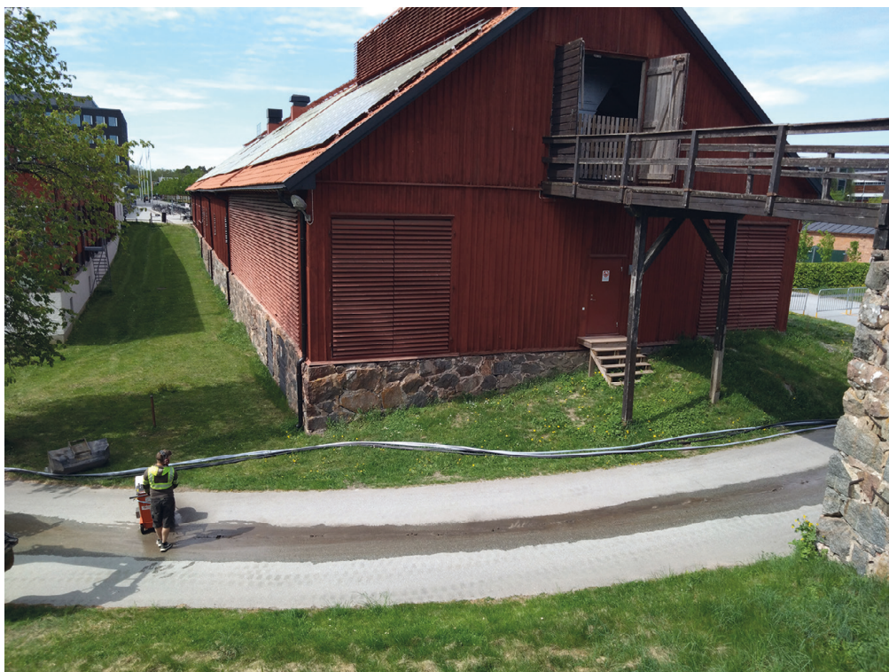
FIGUR 9. Logens östra gavel vid Almas allé efter att schakt 11 lagts igen och före det att schakt 12 grävts. Till höger syns delar av körbron och nere vid marken kan också den ramp (A509) som påträffades anas. Från öster. Foto: Ann Lindkvist.
