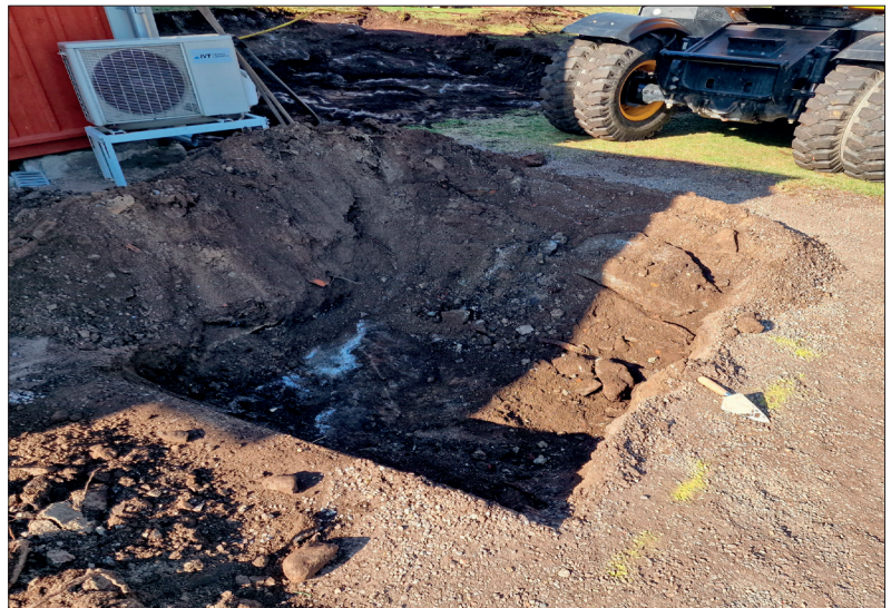
Schakt 2 mot sydväst. Foto: Lars Norberg 2022, Sörmlands Arkeologi AB.
