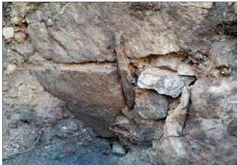
Figur 8. I murväggens utsida påträffades ett ankarslut som satts dit någon gång under 1900-talet. Man kan också se hur man fyllt igen ett hålrum med småsten vid samma tidpunkt. Bilden är tagen från nordöst. Foto: Patrik Gustafsson Gillbrand 2015, Sörmlands Arkeologi AB.
