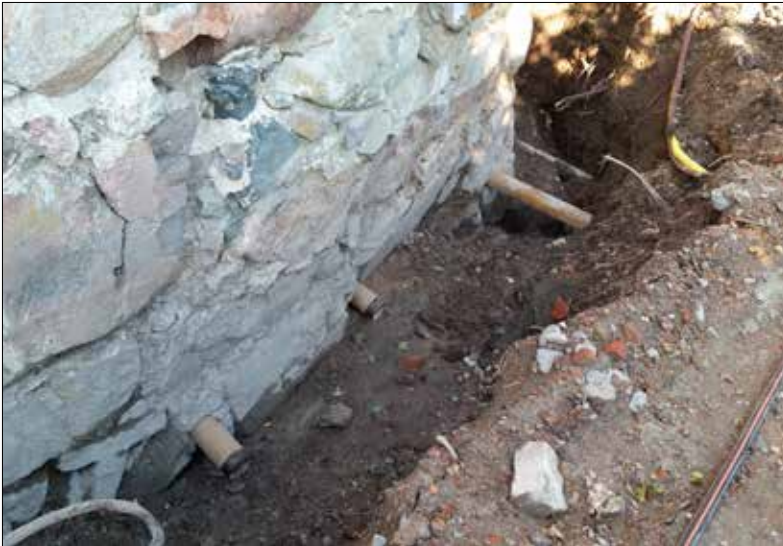
Figur 7. Del av schakt 2 på utsidan av Kanonrondellen. På bilden kan man se hur borrören sticker ut genom murväggen. Bilden är tagen från sydöst. Foto: Patrik Gustafsson Gillbrand 2015, Sörmlands Arkeologi AB.
