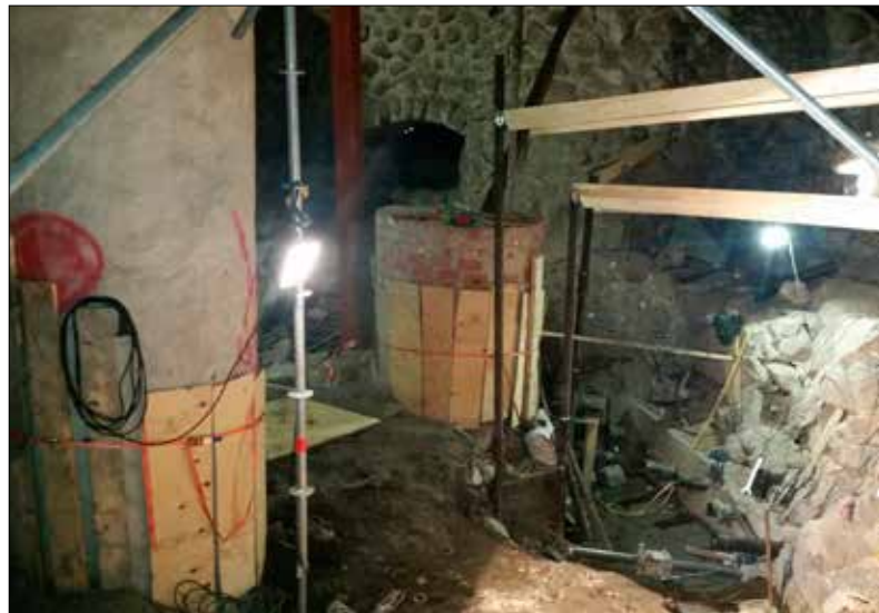
Figur 5. Schakt 1 på insidan av Kanonrondellen. I bild kan man se de två pelarna som fungerade som stöd till det raserade Drottningtornet samt olika förstärkningsåtgärder som skulle förhindra ras i schaktet. Bilden är tagen från sydväst. Foto: Patrik Gustafsson Gillbrand 2015, Sörmlands Arkeologi AB.
