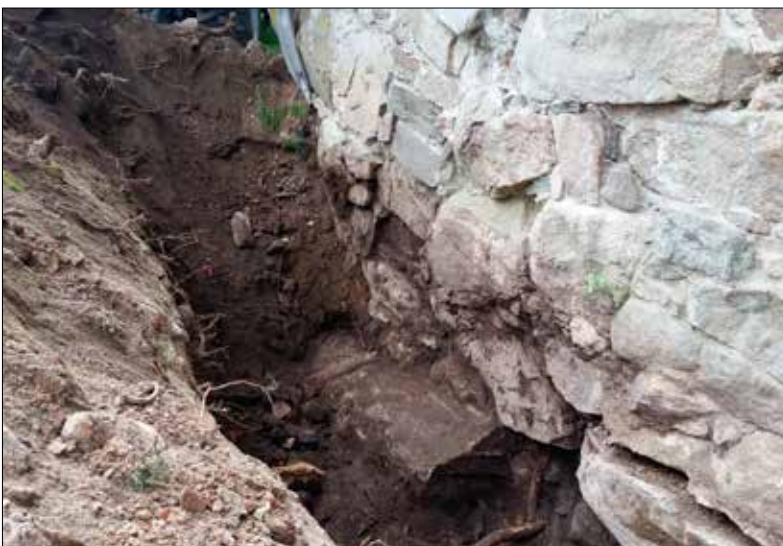
Figur 9. På murväggens utsida påträffades två pågjutna betongförstärkningar. Här ser vi den södra av de två i botten av schaktet. Bilden är tagen från nordöst. Foto: Patrik Gustafsson Gillbrand 2015, Sörmlands Arkeologi AB.
