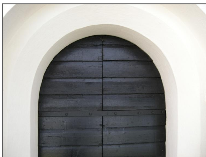
Figur 9. Ljudlucka efter omtjärning.
