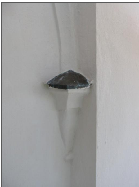
Figur 6. Plåtar anfärgades i en nyans som skulle motsvara övriga detaljer i kopparplåt.
