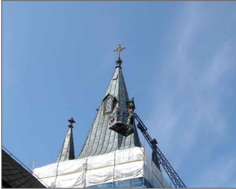
Figur 12. Tornspiran fylldes och tornbuvens fönster målades.
