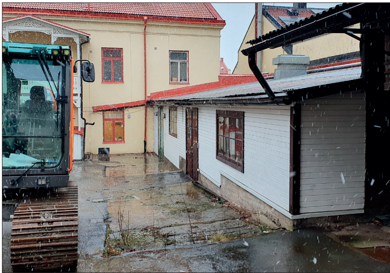
Området för S1 före schaktning. Foto mot nordost: Lars Norberg 2020, Sörmlands Arkeologi AB.
