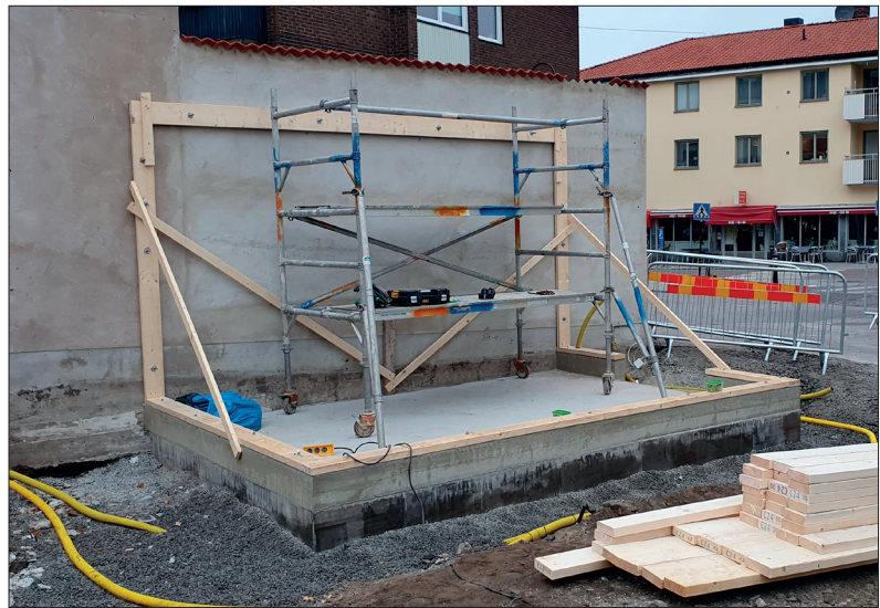
Soprum i anslutning till S2 under byggnation. Foto mot nordväst: Lars Norberg 2020, Sörmlands Arkeologi AB.
