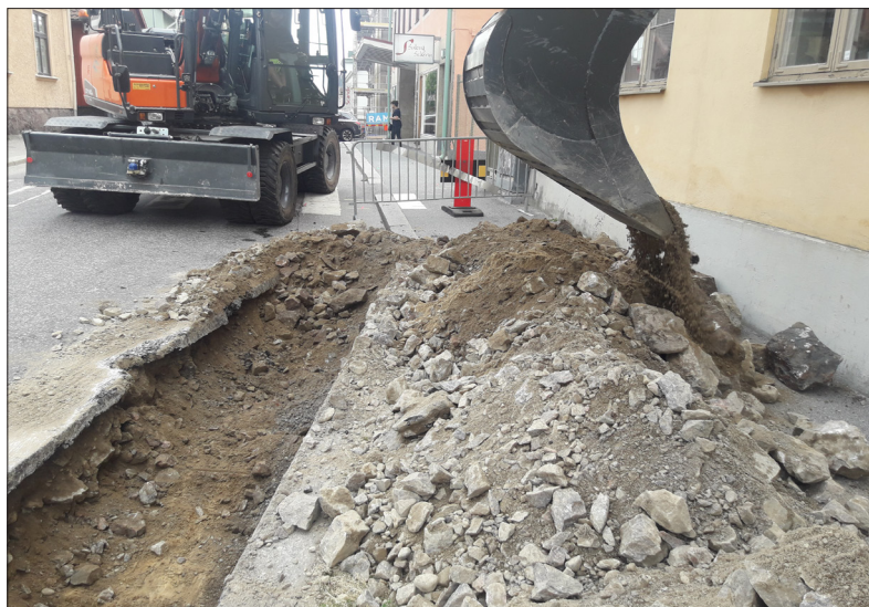
Figur 9. Grävning av ledningsschaktet i Brunnsgatan. I schaktet framkom sprängsten alternativt berg. Bilden är tagen från nordväst. Foto: Patrik Gustafsson Gillbrand 2018, Sörmlands Arkeologi AB.
