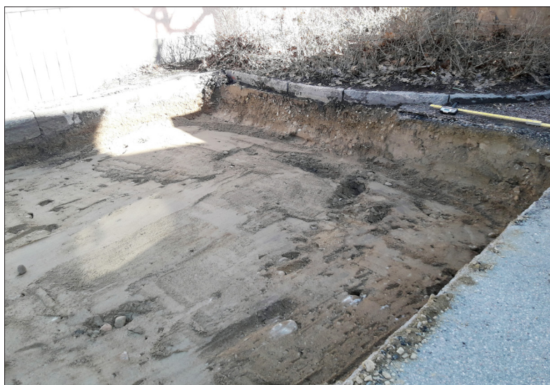
Figur 5. I schaktet för ny nätstation framkom utfyllnadsmassor av sand och grus. Bilden är tagen från söder. Foto: Patrik Gustafsson Gillbrand 2018, Sörmlands Arkeologi AB.
