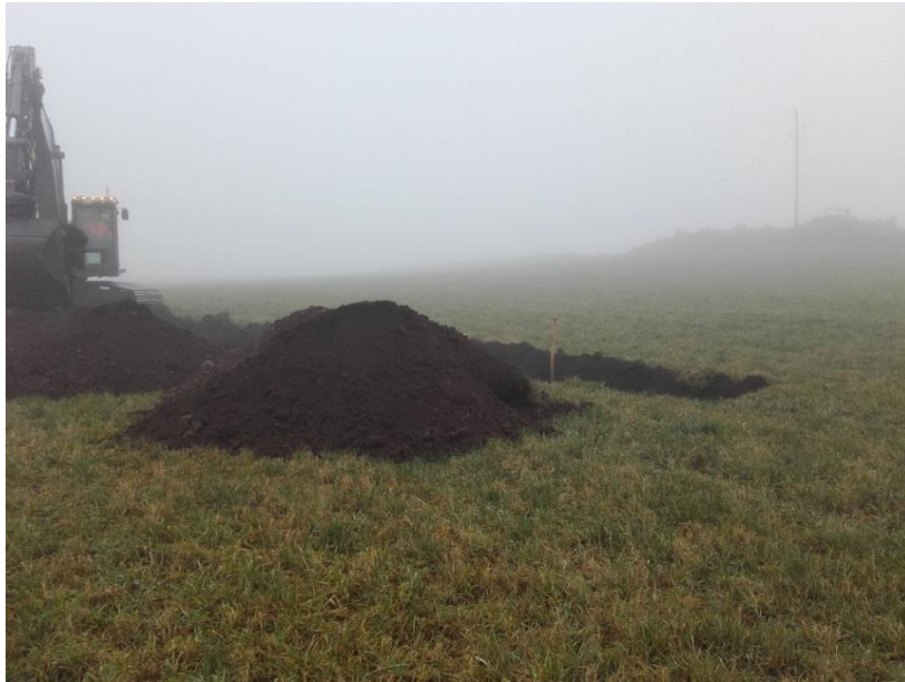
Fig. 3. Schakt 3 drogs förbi stensättningen RAÄ 8:1, som syns svagt i fotots högra del. Från väst.
