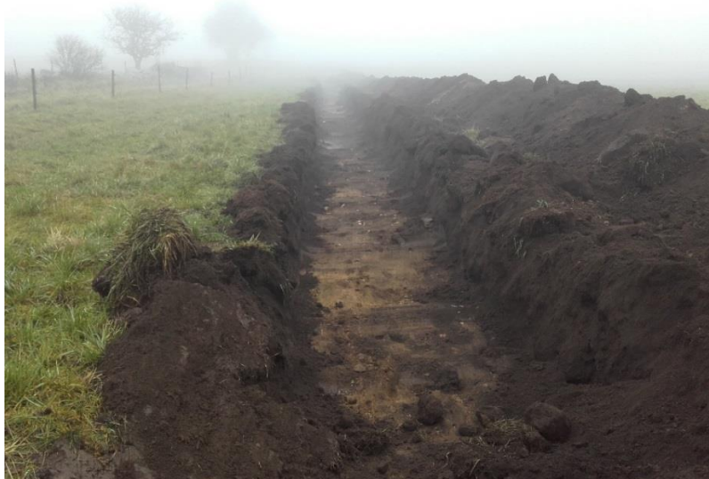
Fig. 4. Det fjärde schaktet drogs förbi stensättningarna RAÄ 55. Foto från sydväst.
