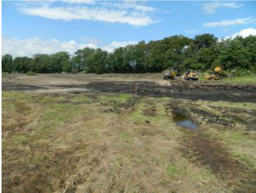
Figur 7. Urschaktningen för våtmarken. A101 syns som ett mörkt organogent lager på schaktbotten. Foto från sydöst.
