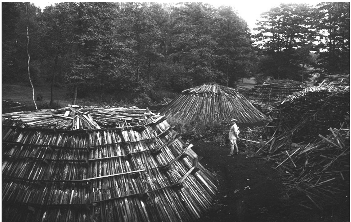
Figur 27. Exempel på uppbyggda resmilor innan de har täckts och tänts på. Bilden är från Virå bruk i Björkvik, Södermanland. Foto av Dan Samuelsson år 1925. Källa: Sörmlands museum, bildnr SLM X2532-78
