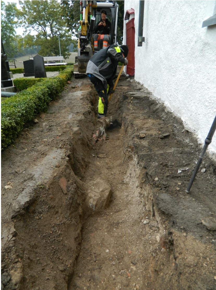
Figur 4. Fotografi över ett av schakten och påträffad sten.
