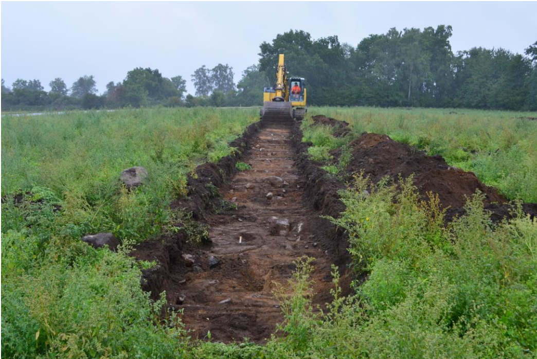
Fig. 6. Schakt 256 med anläggningar under pågående grävning. Foto mot nordost.
