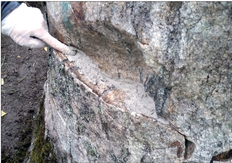
D4 fästes med hydrauliskt kalkbruk. Foto: Lars Norberg 2019, Sörmlands Arkeologi AB.
