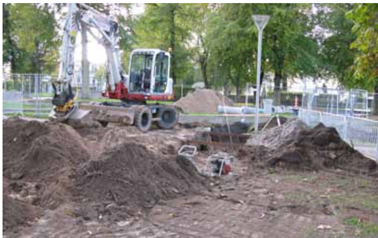
FIGUR 3. Schaktningar inom Hamnparken. Foto från norr.
