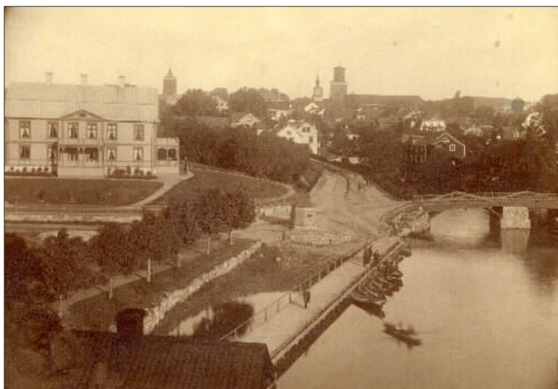
Figur 15. Figur 7. Vy från Kungstornet. Centralt i bilden är Fiskbron. Den kallades även Återbärsbron efter vattenspegeln till vänster om bron. I bildens mitt finns ett pumphus där allmänheten hämtade vatten. I nedre vänstra hörnet syns tvättstugans tak. I bildens bakgrund kan man se nuvarande Godtemplaregården som ursprungligen byggdes av Dr Sacklén år 1789. Bilden är tagen år 1877. Sörmlands museum, bild SLM R148-96-1.
