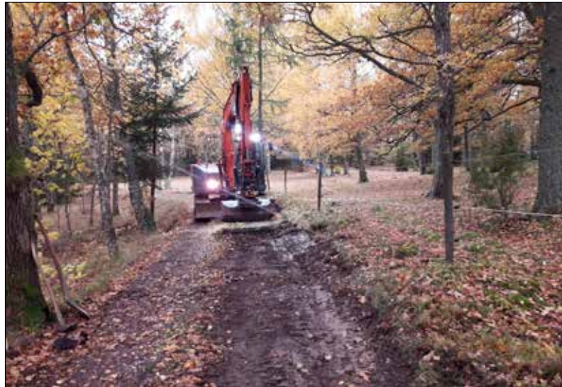
Figur 11. Återställning med hjälp av gräv-maskin intill grav 1. Bilden är tagen från sydöst. Foto: Patrik Gustafsson Gillbrand 2017, Sörmlands Arkeologi AB.
