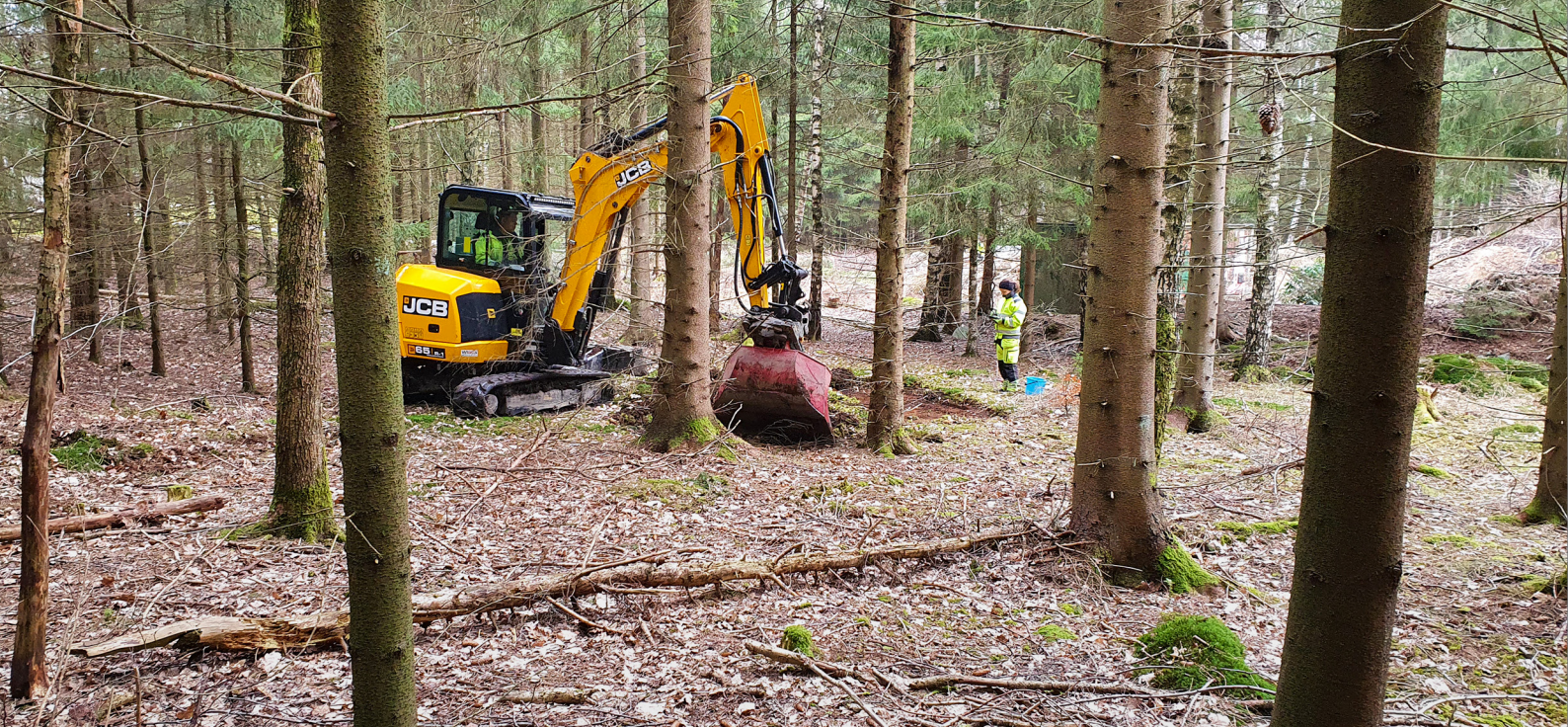
Figur 3. Foto från öster som visar schaktgrävning inom delområde 3. Foto: Mats Hellgren.
