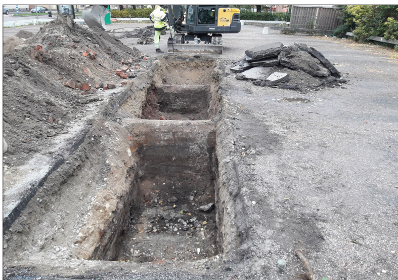
Figur 10. Betongmurar i schakt 7 inom Sågaren. Bilden är tagen från öster. Foto: Patrik Gustafsson Gillbrand 2018, Sörmlands Arkeologi AB.
