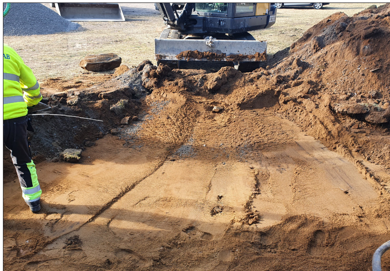
Det övervakade schaktet. Bilden är tagen från öster. Foto: Patrik Gustafsson Gillbrand 2020, Sörmlands Arkeologi AB.
