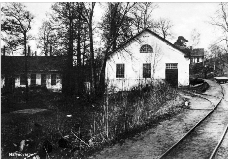
Figur 10. Foto från år 1921 med järnvägen som gick öster om Näveån (objekt 16). Idag är banvallen asfalterad och fungerar som GC-väg. Bilden är tagen från söder. Bild: Järnvägmuseet, bildnummer: Jvm. KCAC11956.
