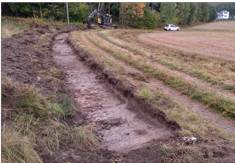
Schakt 4 beläget strax norr om fornlämning 1985:5952. Skogspartiet i bakgrunden döljer grav- & boplatssområdet L1985:6320. Foto mot sydväst: Lars Norberg 2022, Sörmlands Arkeologi AB.
