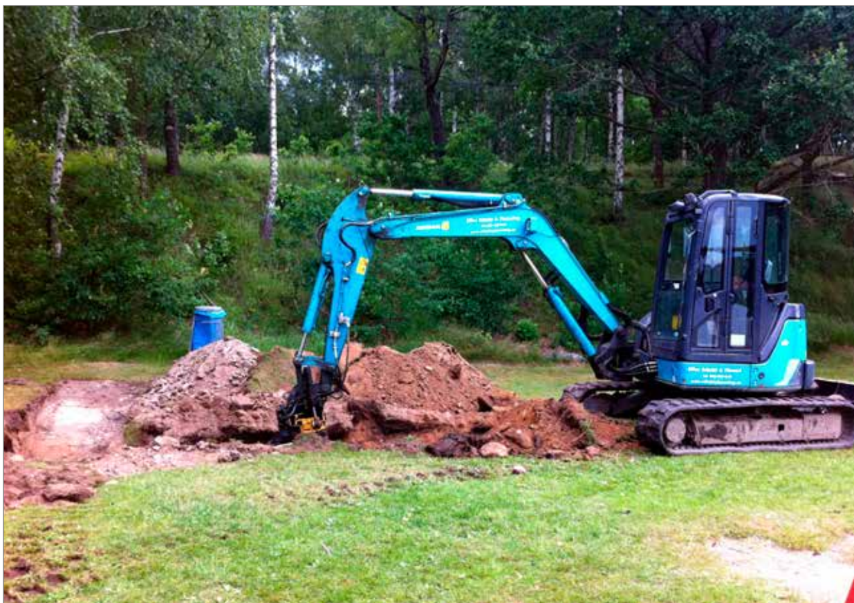
Figur 5 Arbetsbild. Schakt öppnas i nordöstra delen av badplatsen, strax söder om boplatsytan. Foto från väst, Elinor Gustavsson.
