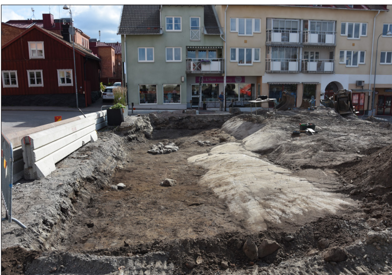
Figur 11. Under bebyggelsen från 1700-talet framträdde flera lager samt rester efter en byggnad. På ytan mellan bergklacken till höger och schaktväggen till vänster, närmast kameran, kan man se en ensamliggande sten. Den har fungerat som en syllsten och ingick i en byggnad (kontextgrupp 5). Bilden är tagen från västnordväst. Foto: Lars Norberg 2017, Sörmlands Arkeologi AB.
