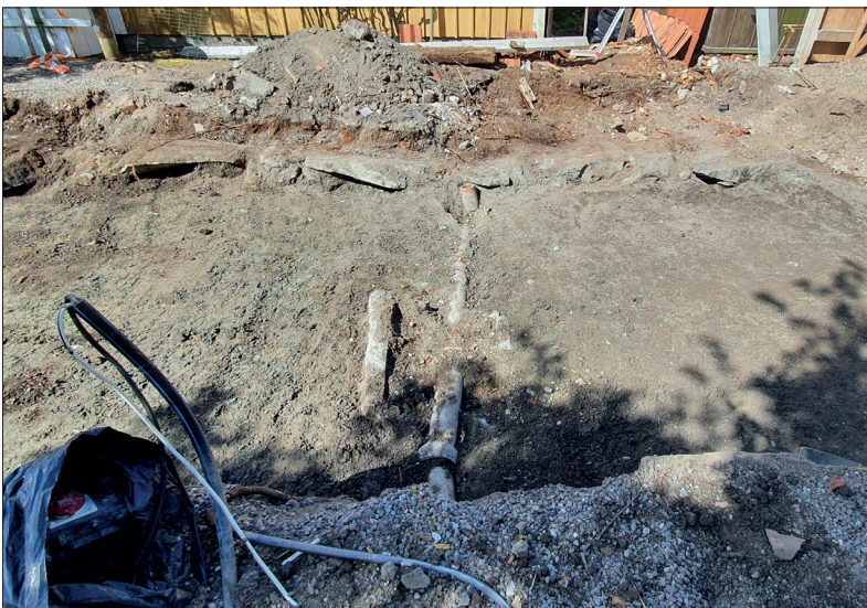
Befintlig avloppsledning och delar av uthu- sets grundläggning. Foto mot väster: Lars Norberg 2021, Sörmlands Arkeologi AB.
