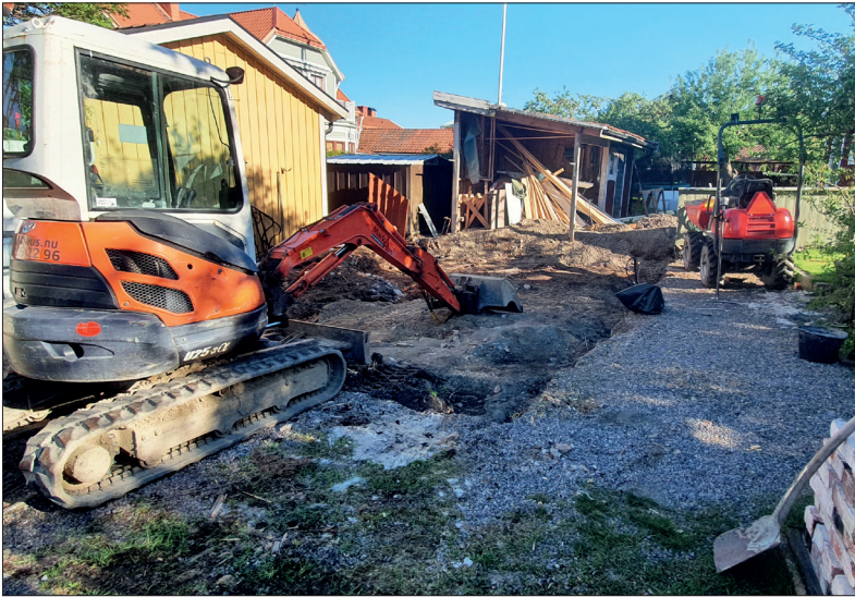
Undersökningsområdet före schaktning. Foto mot nordnordväst: Lars Norberg 2021, Sörmlands Arkeologi AB.
