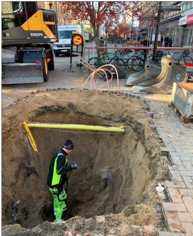
Figur 3. Foto över schaktet i korsningen Drottninggatan/Östra Torggatan. Foto från öster.
