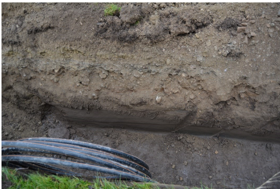
Figur 22. Lager av olika material i vägbanan. Foto mot väster. Foto: Simon Rosborg, Sydsvensk Arkeologi.
