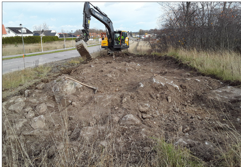
Den avbanade ytan inom den sydvästra delen av undersökningsområdet (S1). Bilden är tagen från VSV. Foto: Ingeborg Svensson 2019, Sörmlands Arkeologi AB.
